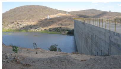
Figura 2 – Barragem Mamoeiro na cidade de Antonina do Norte.
